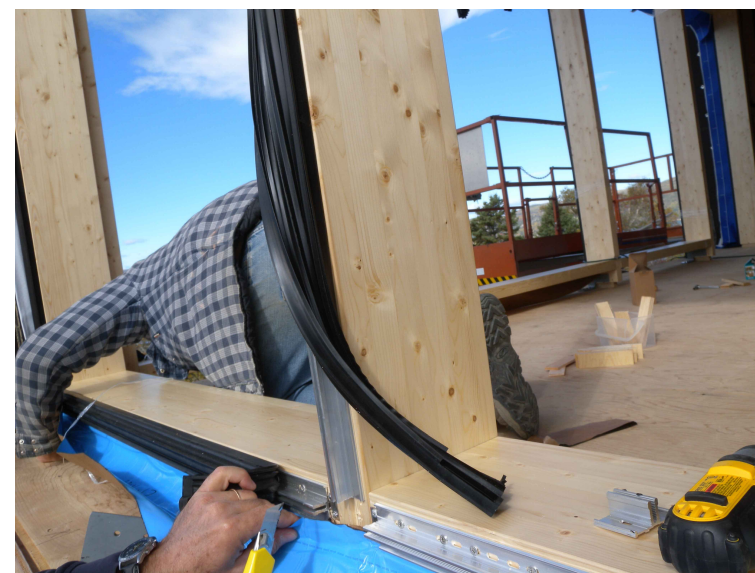
PHOTO 2: VOIR DESCRIPTION DE L'ÉTAPE 2
