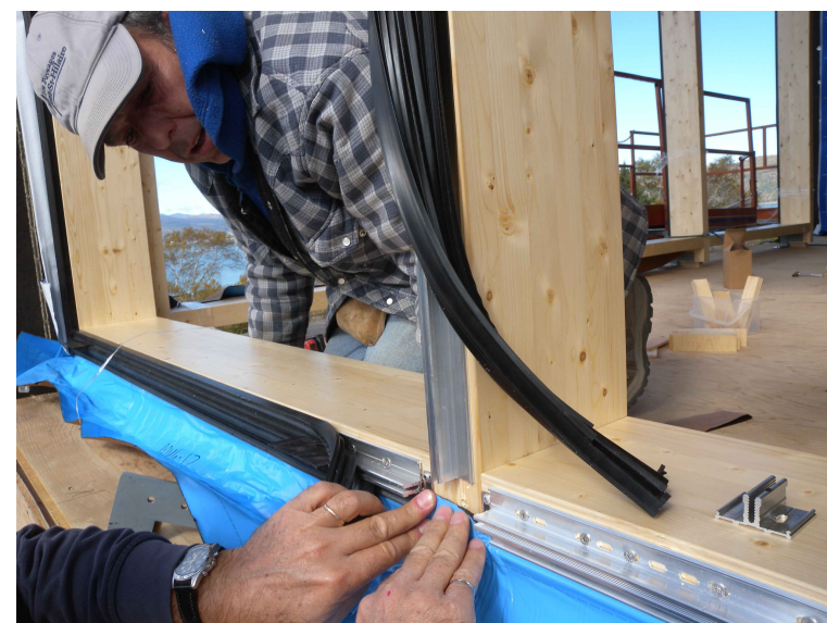
PHOTO 3: VOIR DESCRIPTION DE L'ÉTAPE 3
