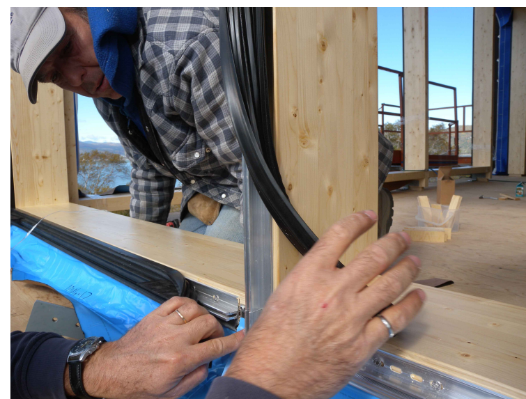
PHOTO 4: VOIR DESCRIPTION DE L'ÉTAPE 4
