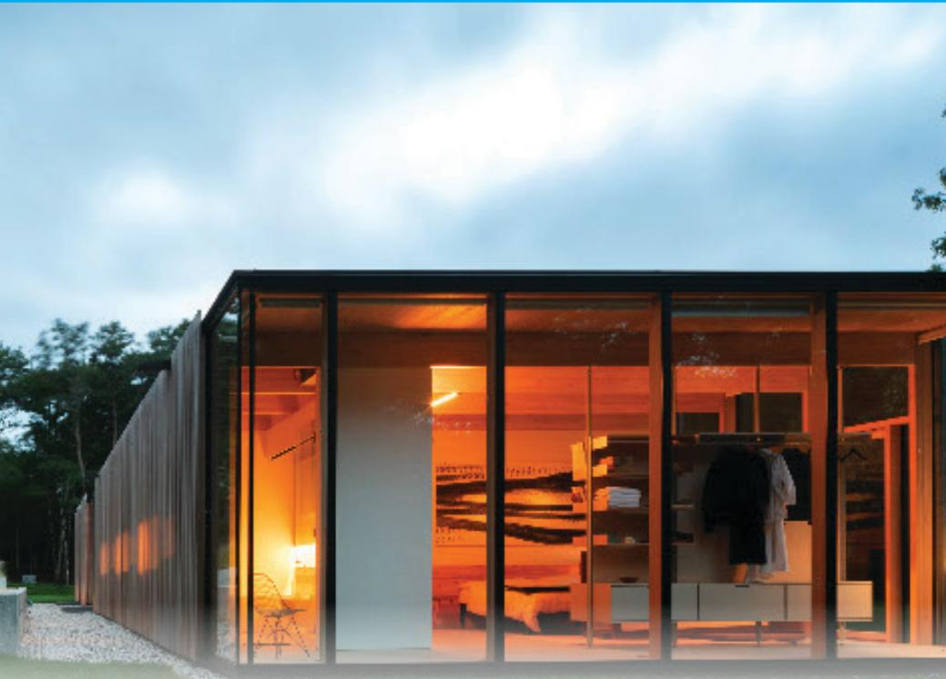
« Le mur-rideau - vitrage, colonnes porteuses, poutres, platelage de toitures, portes et fenêtres inclus - a été livré en quelques camions et assemblé sur place en six jours. Une solution simple, pragmatique et uniforme. »
